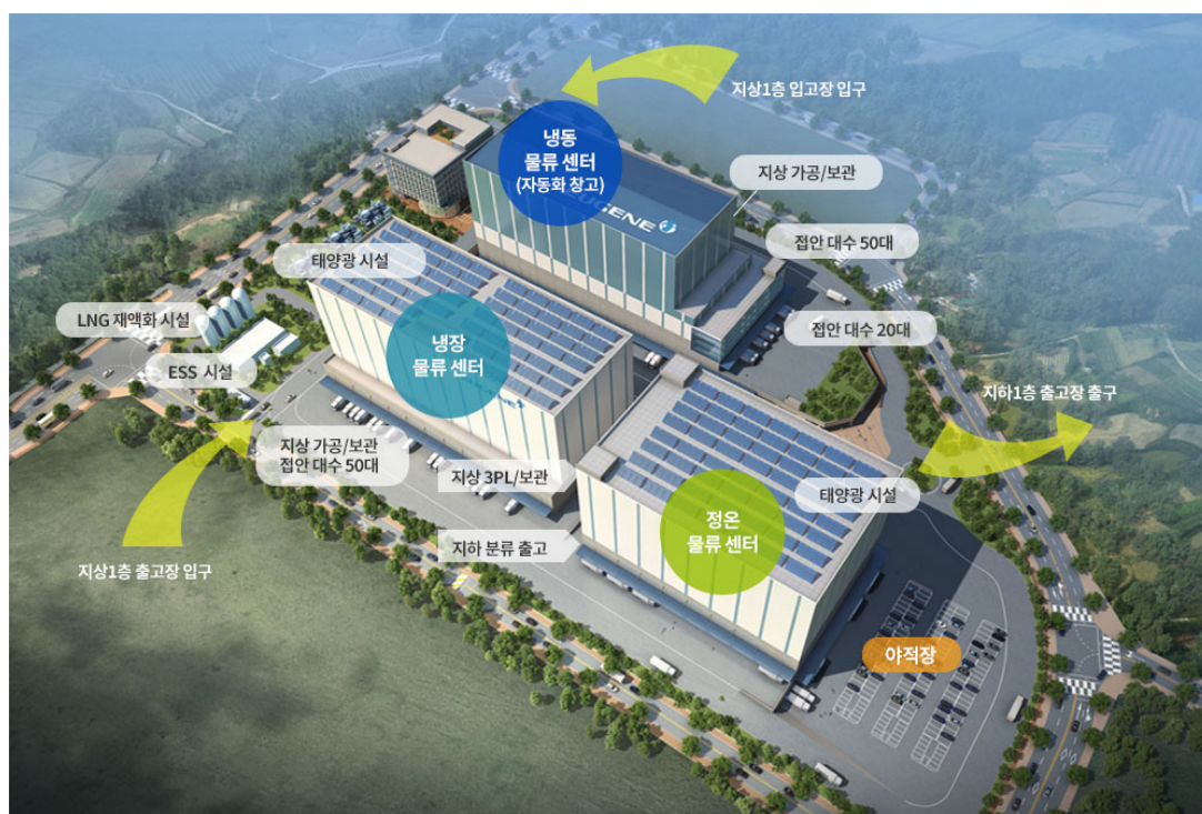
〈그림 5-10〉 에너지 자립형 초저온 냉동·냉장창고 조성사례
