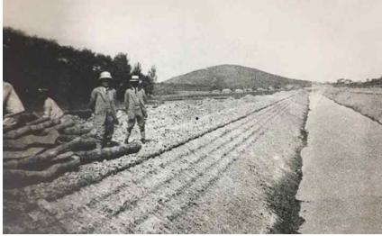
[그림 2-23] 대간선수로 공사 모습
