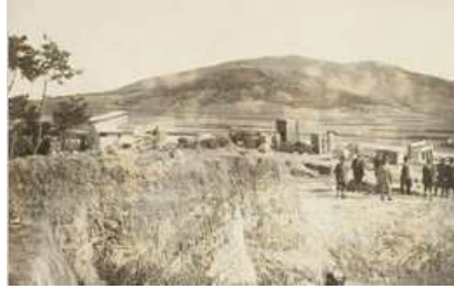
[그림 2-24] 양수기 설치 기초공사
