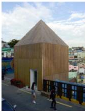
부산 김천문화마을 내 입주할 건축계의 편집 리모델링 작품인 '레지던스'와 '개도로'를 건설중
