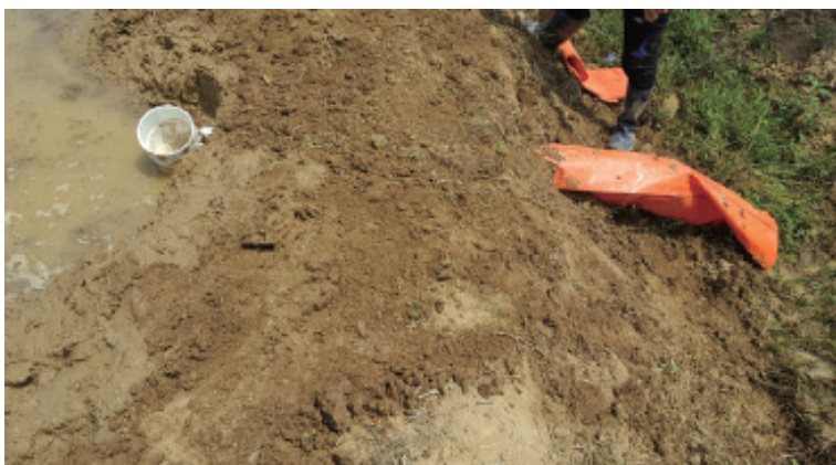
[그림 4-8] 논두렁에 설치한 배수물꼬 사례
