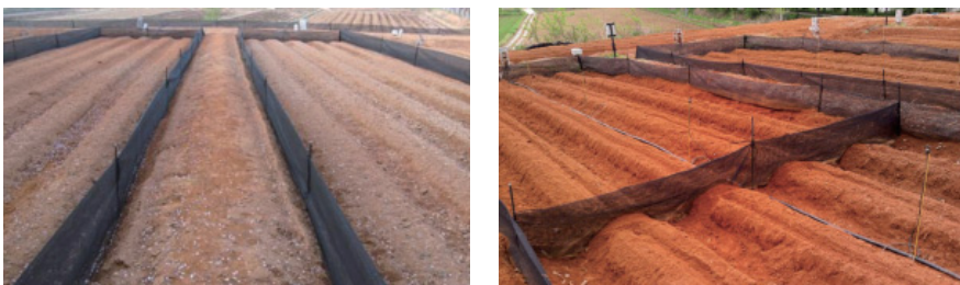
[그림 4-10] 실트펜스 설치 예
