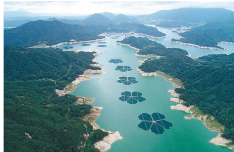
〈합천 수상태양광 심미적 효과 사례〉
