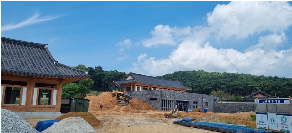
[그림 2-8] 한국학미래진흥원 건설 현장(2025.7.2. 필자 촬영)
